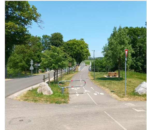
Passerelle cycliste Waltenheim-sur-Zorn Source : ATIP
