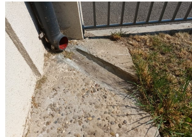
Déraccordement des eaux de toiture, école de Muttersholtz Source : ATIP
