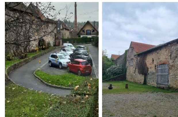
Parking des remparts avant réaménagement urbain Source : DNA
