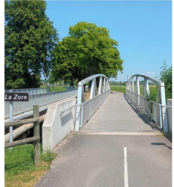
Passerelle cyclable à Waltenheim-sur-Zorn Source : ATIP
