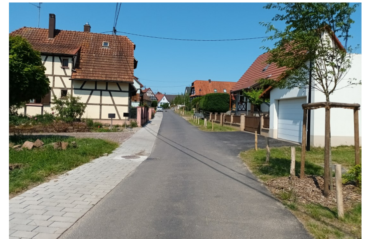
Rue de la forêt, après travaux d'aménagement (2022)
